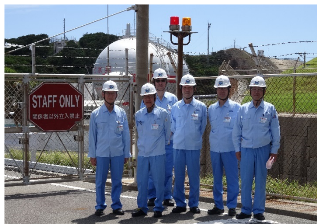
液化水素貯蔵供給所エリア
