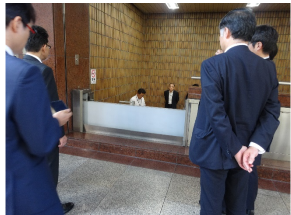
止水板設置状況
