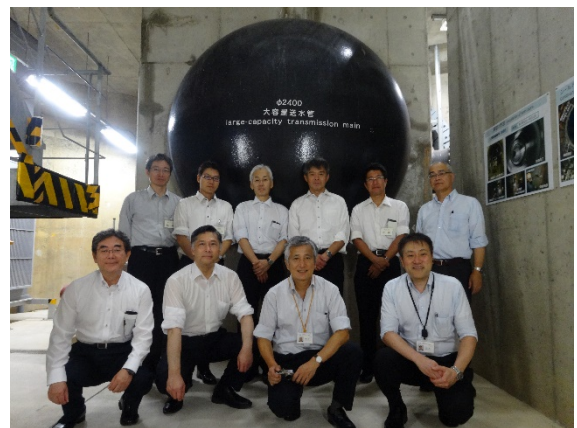
立坑内の大容量送水管
