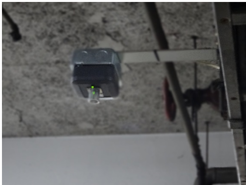
セントラルパーク地下駐車場の超音波ビーコン
