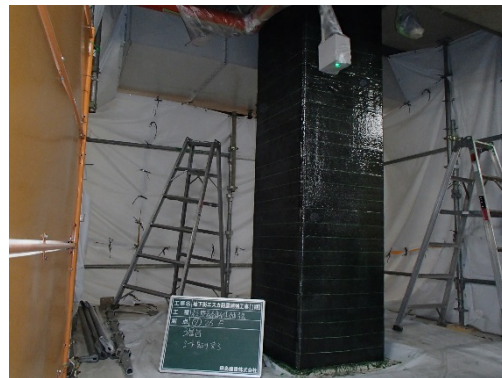
エスカ地下駐車場の工事
