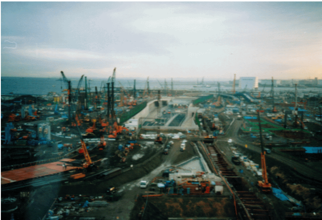
工事中の沈埋トンネル出口付近
