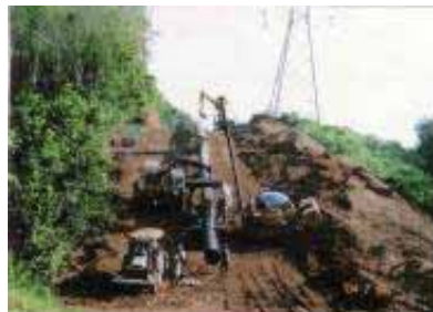
写真7. 海外の施工事例
