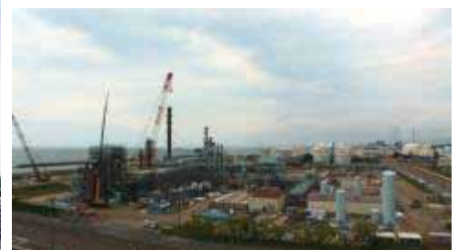
写真10. 天然ガスの液体燃料化技術(GTL)の実証試験設備建設風景 (日本GTL技術研究組合提供)
