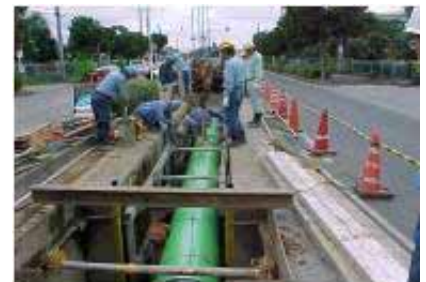
写真8. 国内の施工事例
