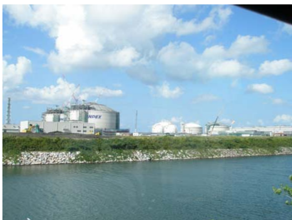
バスより望む直江津LNG基地と発電所
