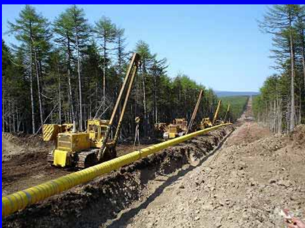
ロックシールドを巻いたパイプの吊り下ろし
