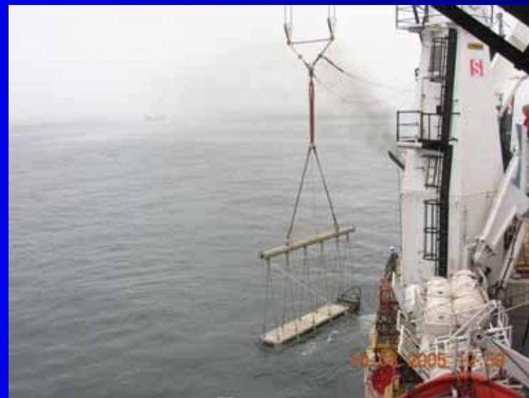
アノードスレッドの設置
