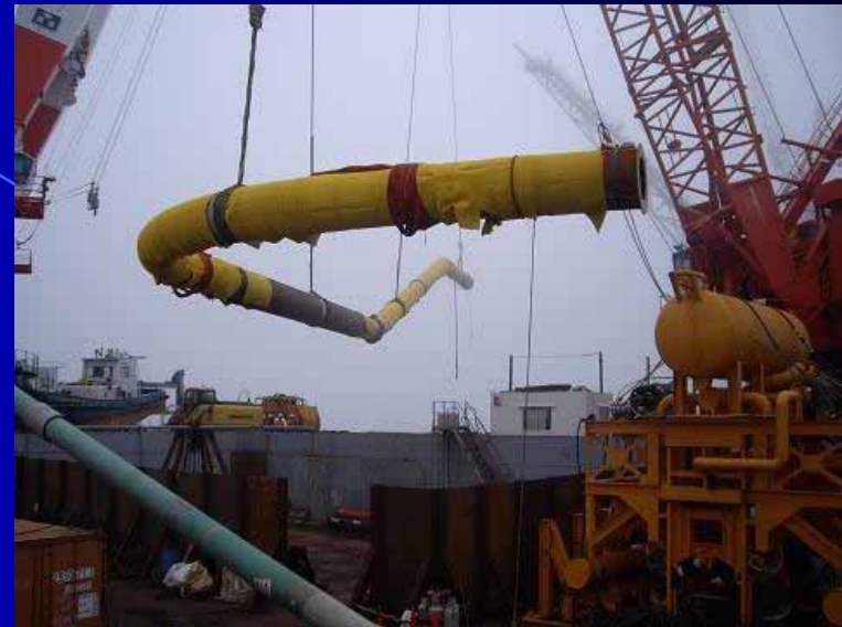
タインスプールの加工及び施工
