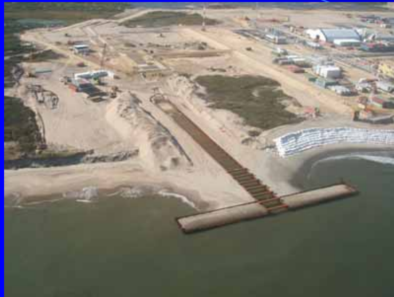
パイプライン引込用コファダム
