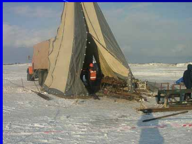
氷上からの土質調査ボーリング
