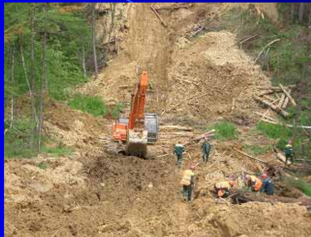
伐開および通路造成
