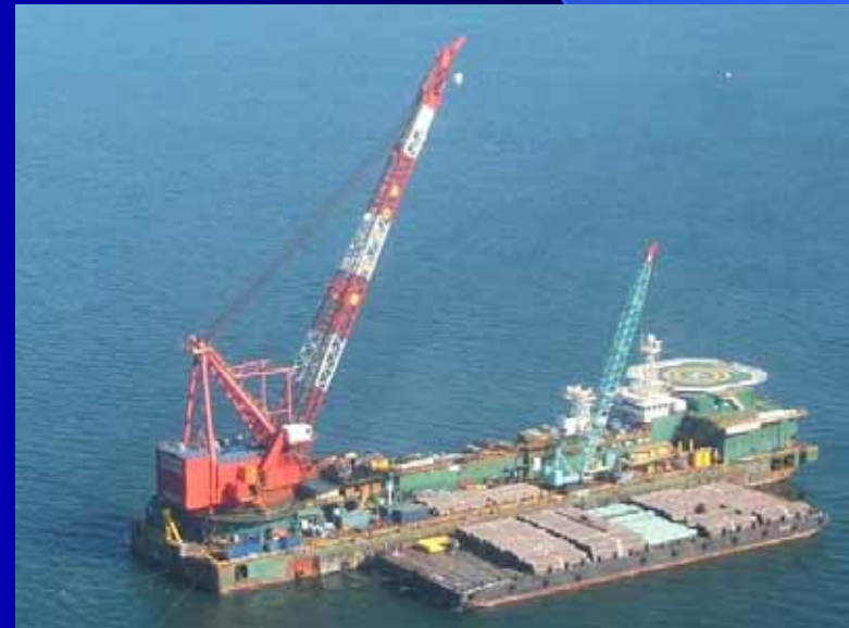
24" & 36"パイプラインの敷設(第二くろしお)
