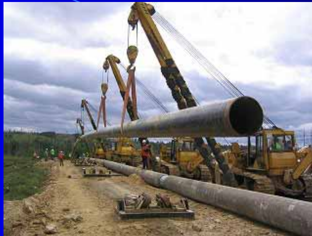
弧状推進(パイプ引き込み)
