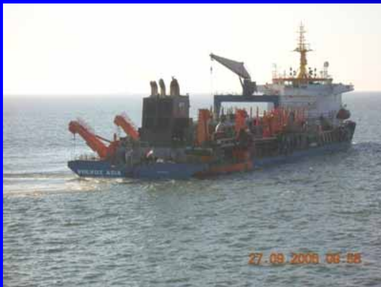
パイプラインルートの前浚渫(全線)
