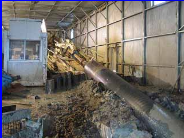
弧状推進(冬季屋内施工)
