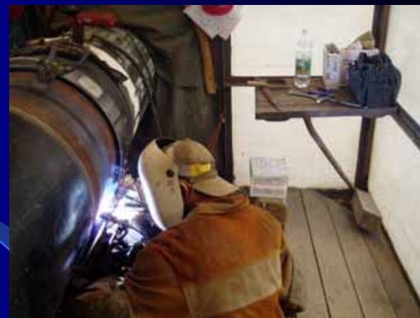
外面からの積層溶接
