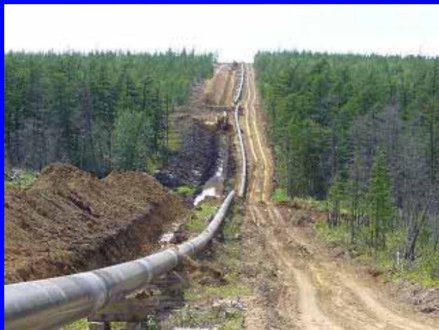
掘削(バックホウ)
