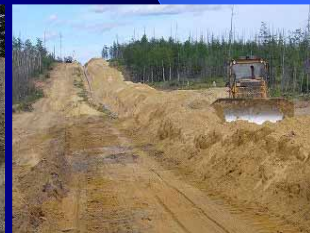
埋め戻し状況
