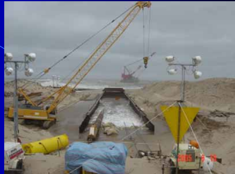
パイプラインの引き込み状況
