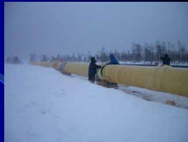
水圧テストのためのパイプ加温工事
