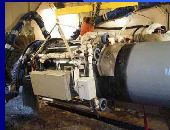
現地塗覆装機
