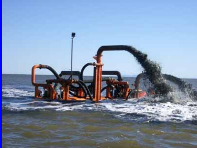
パイプラインの埋め戻し
