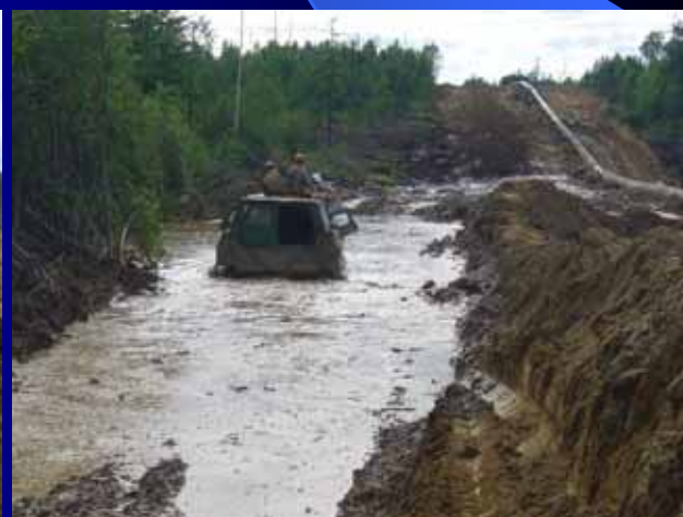
泥水が溢れるパイプライン建設現場
