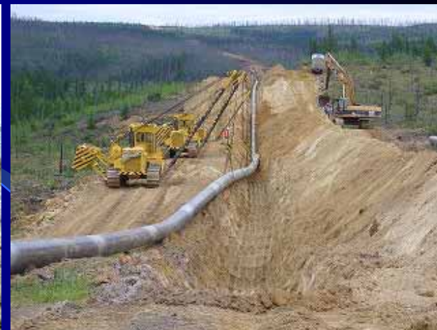
吊り下ろし(サイドブーム)
