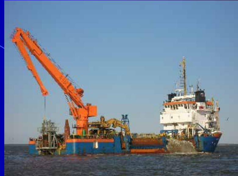
流氷によるパイプライン損傷防止のための石積み工事
