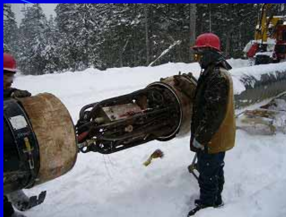
内面からの初層溶接
