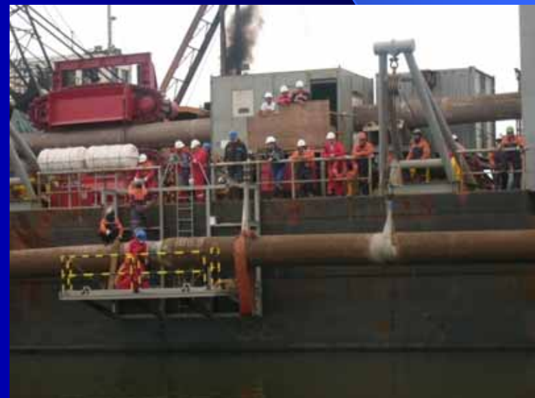
作業船によるパイプライン接続
