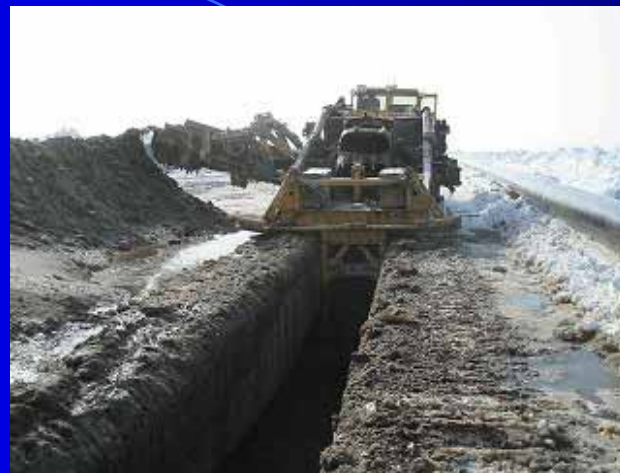
掘削(トレンチングマシン)
