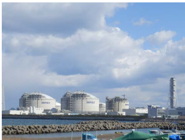
直江津 LNG 基地全景
