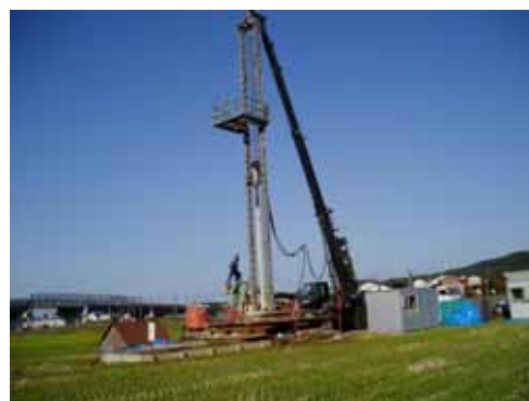
図-3 安田鉱山坑井確認作業
