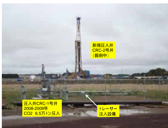
Otway プロジェクト現地施設
