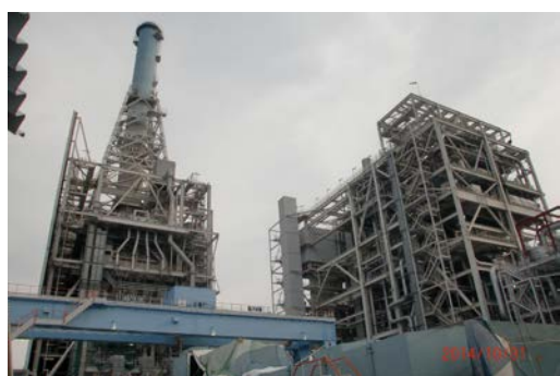
排熱回収ボイラ(左)とガス化炉設備(右)
