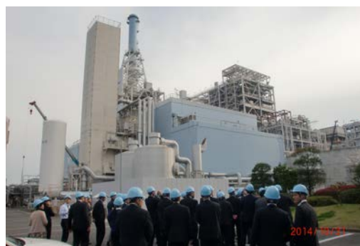
空気分離設備(白建物)と中央操作室(青建物)
