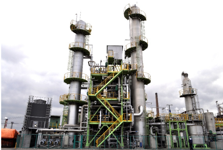
CO 2 回収設備
