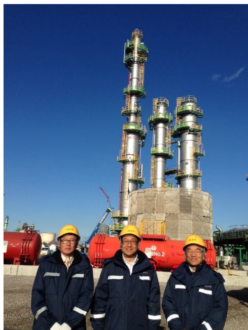
分離回収装置（吸収塔、フラッシュ塔）
