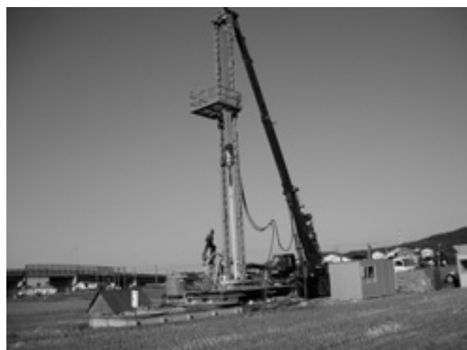
図3 安田鉱山坑井確認作業
