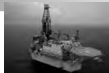
テランガス田開発井掘削リグ
