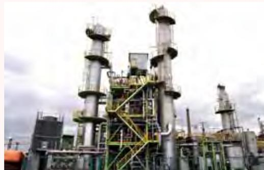
設備能力：120ton/日 原料ガス：製鉄所熱風炉排ガス
