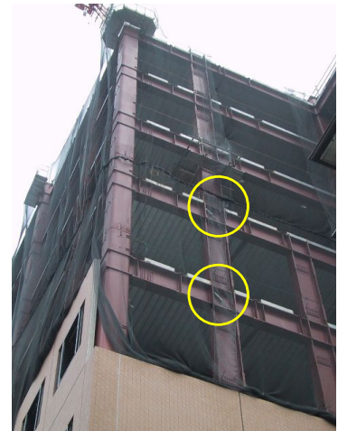
(1) 建物外観 (2) 間柱制震ダンパ (3) FBG変位計の設置
