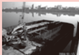
台湾・台北地下鉄新莊線570C工区 建設プロジェクトチーム
