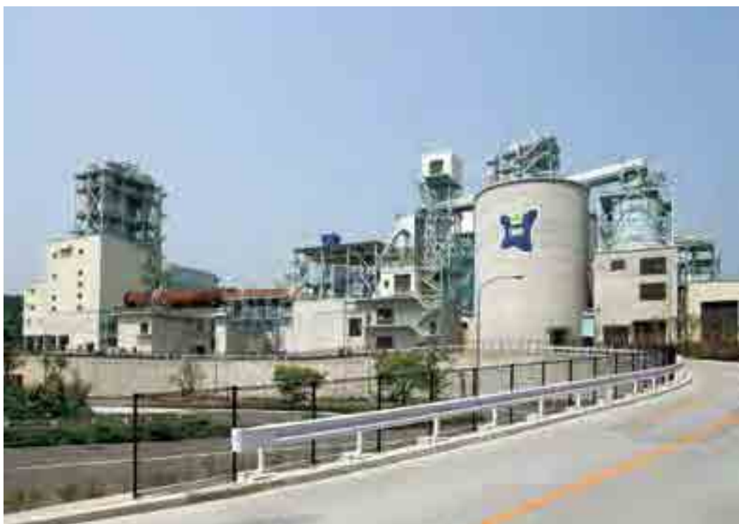
東京たまエコセメント化施設建設工事(H18/7竣工)
