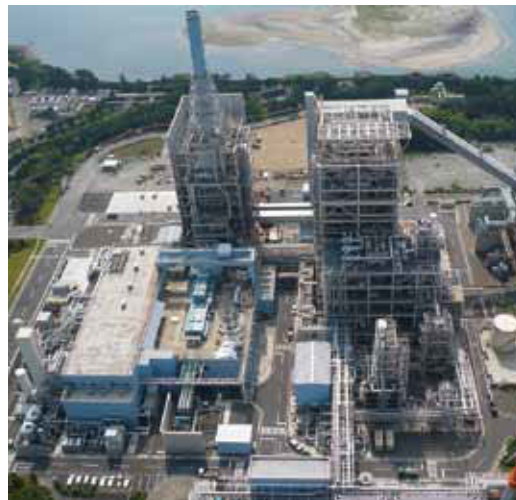
常磐共同火力株式会社殿向け 勿来発電所10号機 (IGCC)
