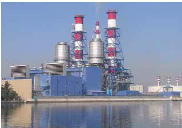
インドネシアPT.PLN殿向け ムアラカラン火力発電所 (GTCC)
