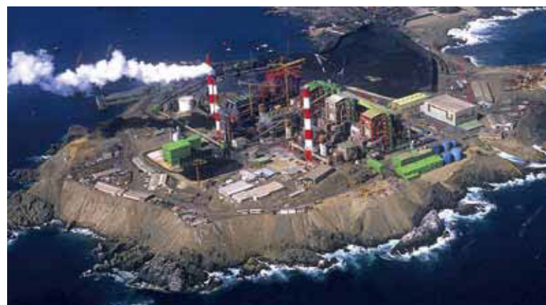
チリ Guacolda Energia S.A.殿向け グアコルダ発電所 (石炭焚き)
