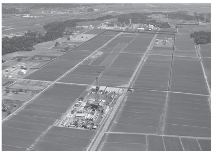
写真-1 フローライン敷設ルート
