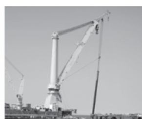
図3 杭撤去作業状況
