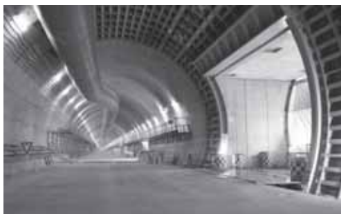
Uターン路完成時
