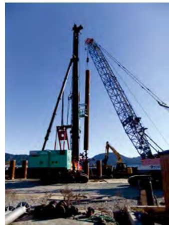
(1) 現地（岩手県山田漁港）での鋼管杭打設状
