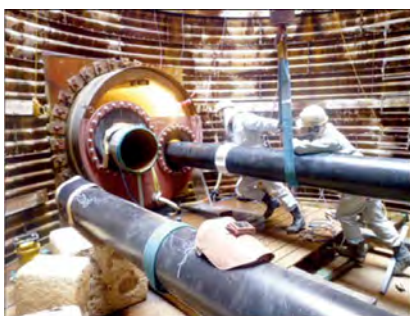
本管押込み状況
