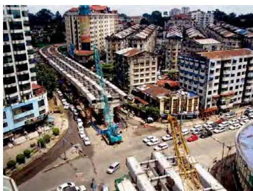
建設中の状況
