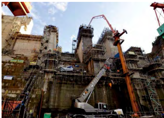
洪水吐（こうずいばき）施工状況
