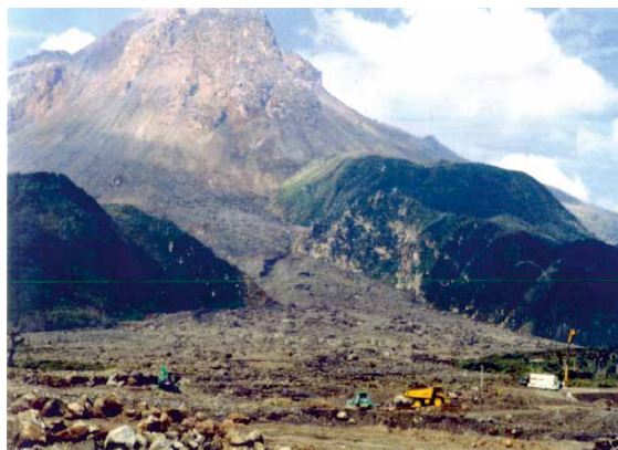
雲仙普賢岳での無人化施工状況
