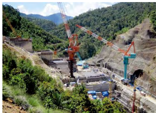
ダム堤体コンクリート打設状況
