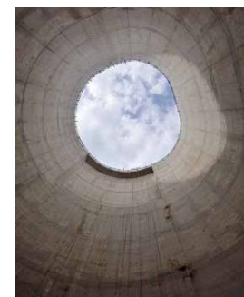
深さ47mの到達立坑
