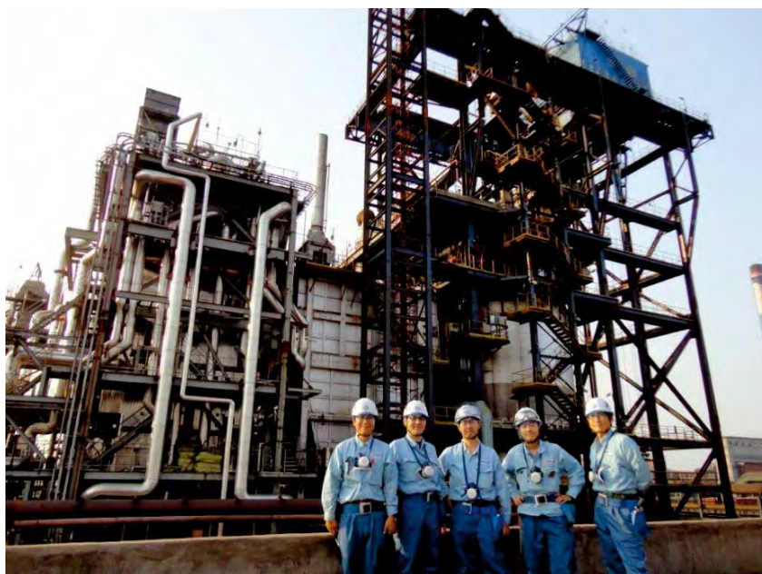
JSW 社向け CDQ 1号機完工
