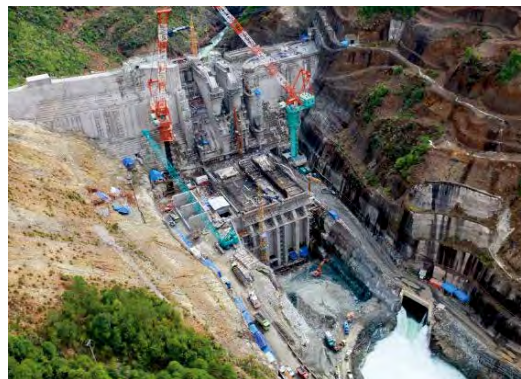
発電所施工状況
