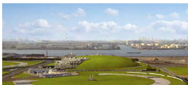
LNG 地下タンク外観 (覆土式)
