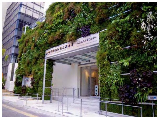
施工事例「とくぎんトモニプラザ」
