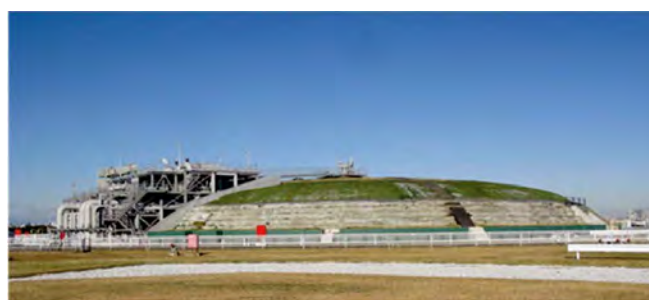
LNG 地下タンク外観 (覆土式)
