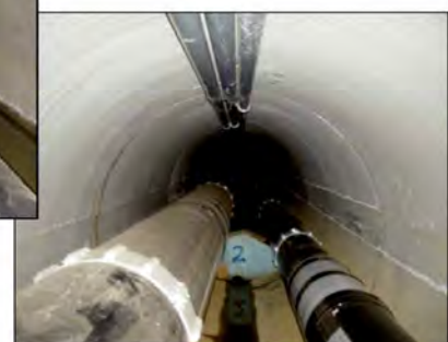
排水後本管設置状況
