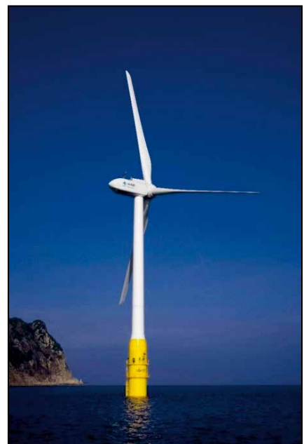
2 MW実証機完成
