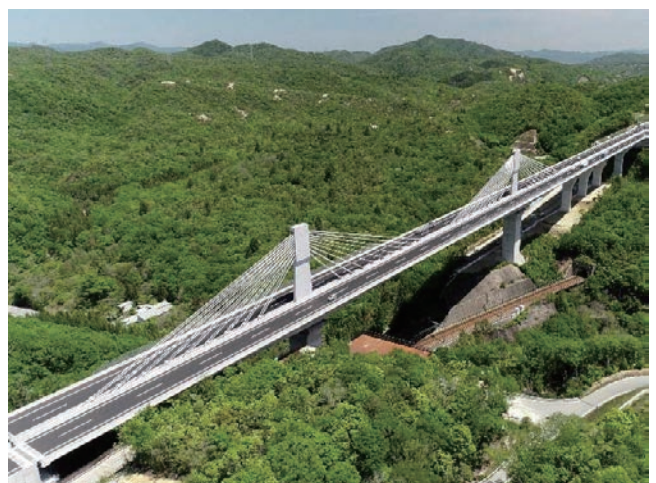
供用後の生野大橋の全景
