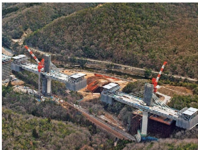
超大型作業台車による張出施工中の全景 (1 サイクルで 8m を張出し施工し 3 か月回復)
