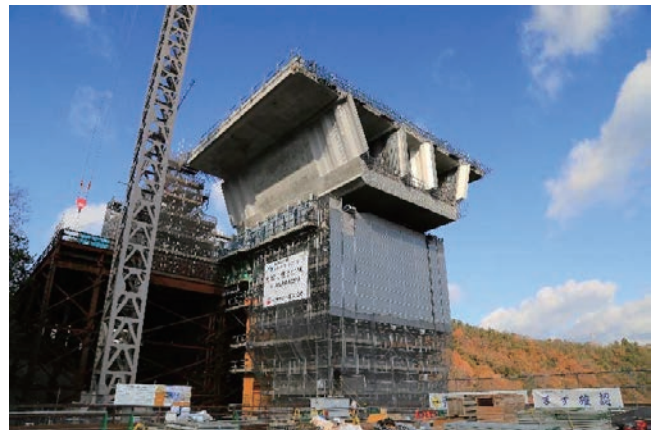
P6 柱頭部の押出し後の状況
