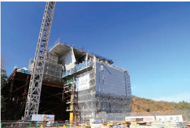
P6 柱頭部の押出し前の状況
