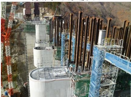
L2 地震動対策の補強鋼材設置状況
