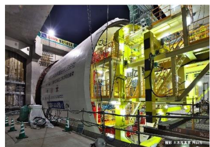
小土被り発進のシールドマシン
