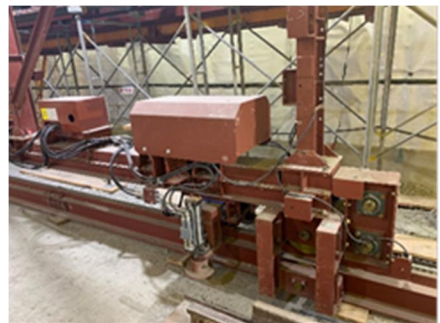
急曲線山岳トンネルでの使用例
