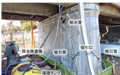
写真 1 簡易給水方式の適用事例（橋脚の再アルカリ化）
