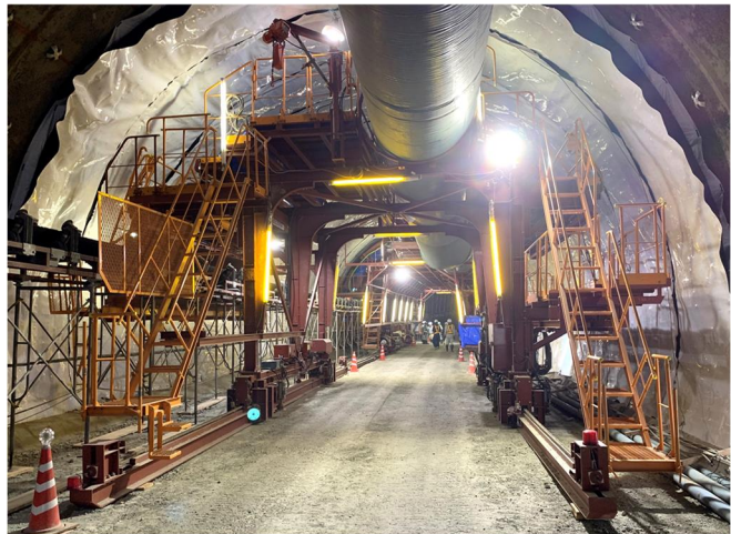
レールウォーカーシステムの概要図
