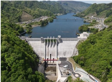
完成時のハツ場ダム
