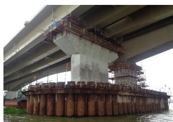
鋼管矢板井筒工法
