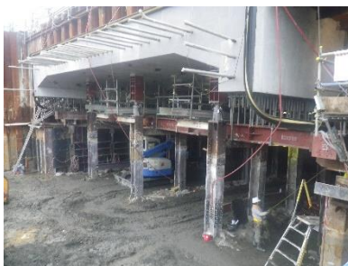
アンダーピニング掘削状況
