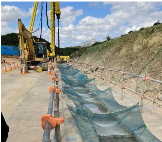
地下連続止水壁（ガイドウォール）
