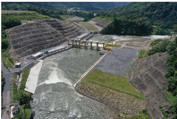
取水堰・取水設備
