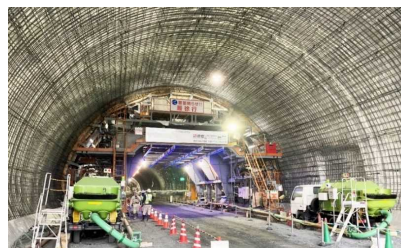
実工事への適用状況
