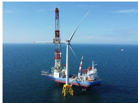
BLUE WIND による風車組立状況
