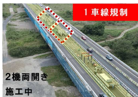
平日工事状況（1車線規制）
