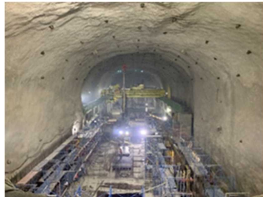
地下発電所躯体工事
