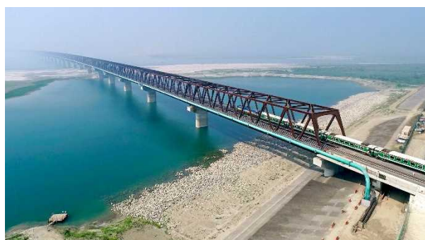
完成した鉄道橋
