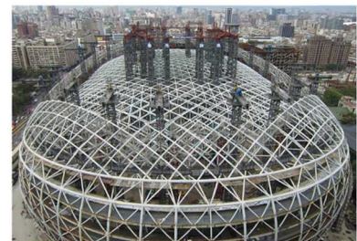
図-4 二次リフトアップ施工中
