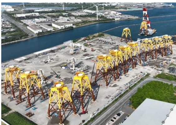
ジャケット式基礎の製作状況
