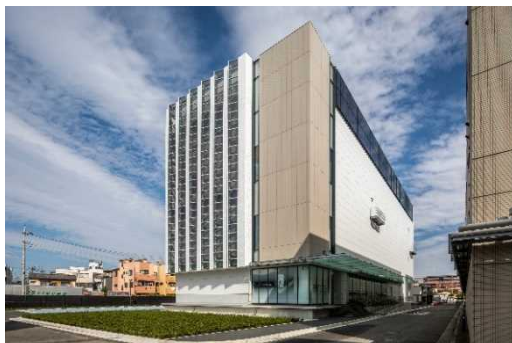
【T-Green® Multi solar を採用した 環境ファサードデザイン】
