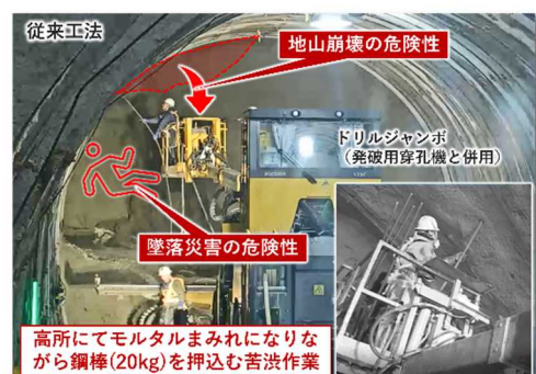
従来のロックボルト施工
