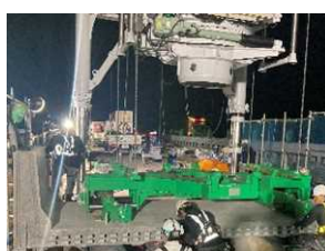
床版設置状況（少人化）
