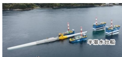
図-5 半潜水台船を用いた進水
