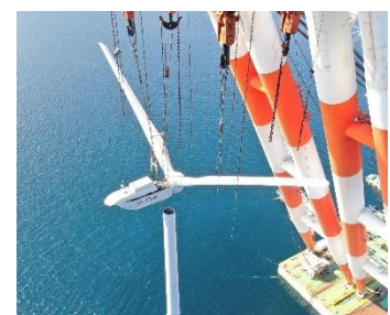
図-6 ラビットスタイル風車の搭載
