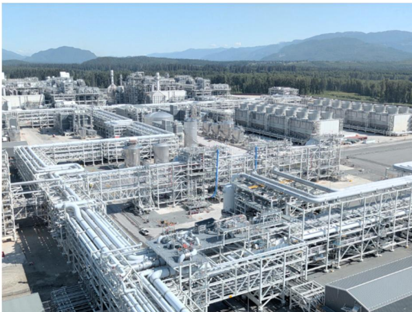
LNG Canada プロジェクト全景
