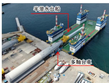
図-4 半潜水台船を用いた浜出し
