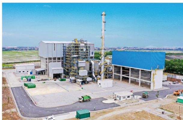
完成廃棄物発電プラント全景
