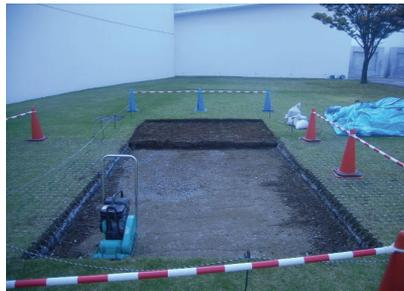
路盤碎石締固め
