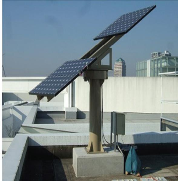
写真3.3.1-1 研究施設屋上に設置した太陽光追尾型発電装置
