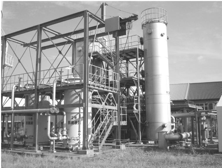
図.3-1-2 吸収塔（後方）の例（金沢市臨海水質管理センター）
