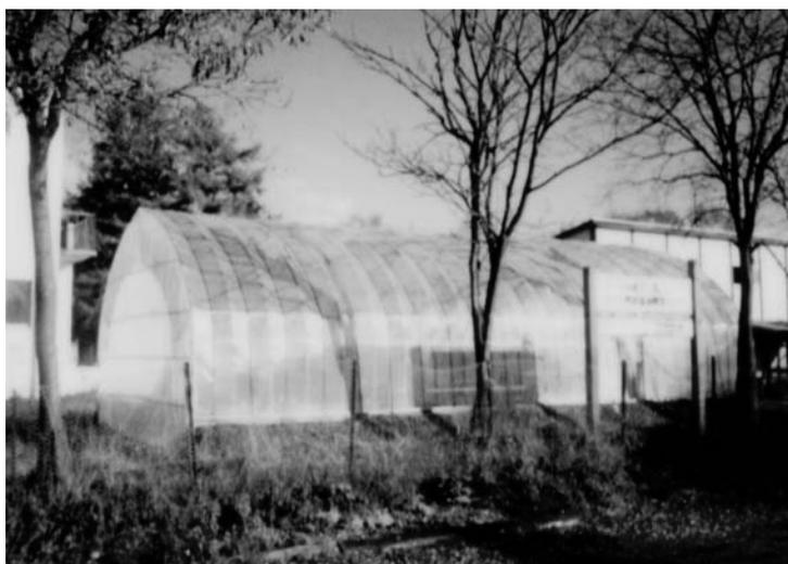
図.2-1-32 温室方式の無加温メタン発酵試験施設
