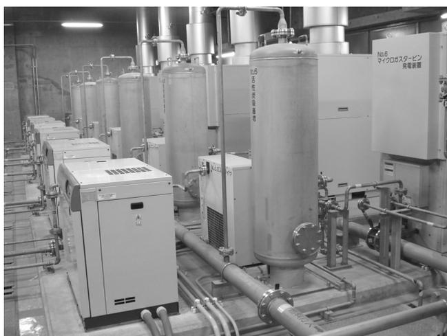
図.2-1-13 マイクロガスタービン発電機
