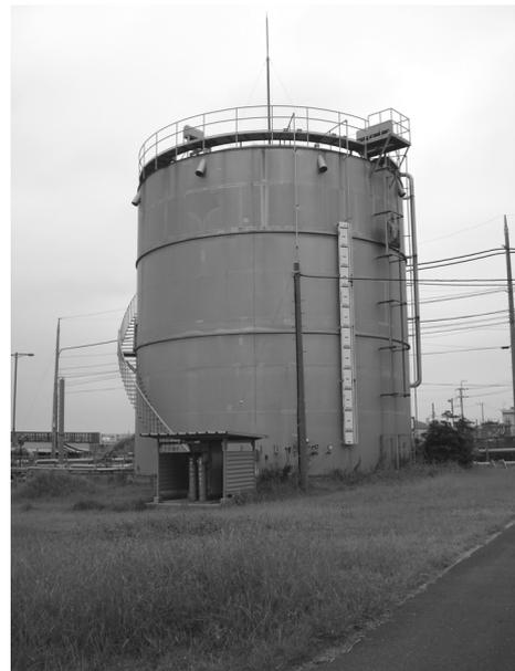
図.2-1-12 容積 1,000m<sup>3</sup> ガスホルダー
