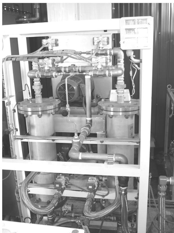
図.3-1-5 減圧再生方式の PSA (細澤牧場設置)
