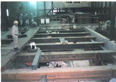
写真 5.2.2-6 防振装置による防振覆工
