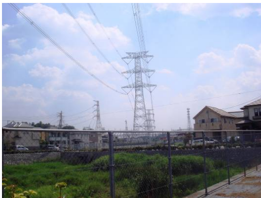
図 2.2-7 送電線下調整池
