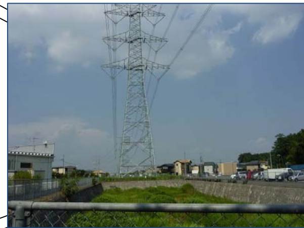
架空線敷設地域の事例
