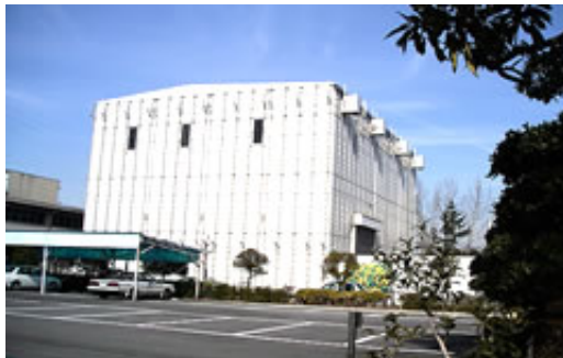
写真 5.2.2-1 防音ハウス例 1
