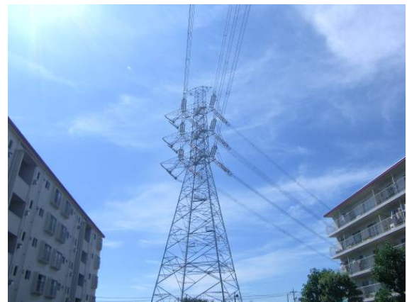
図 2.2-14 集合住宅内架空送電線
