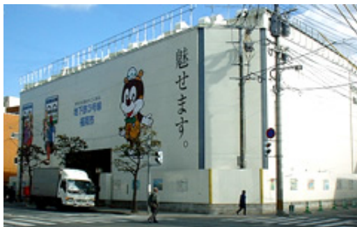
写真 5.2.2-3 防音ハウス例 2
