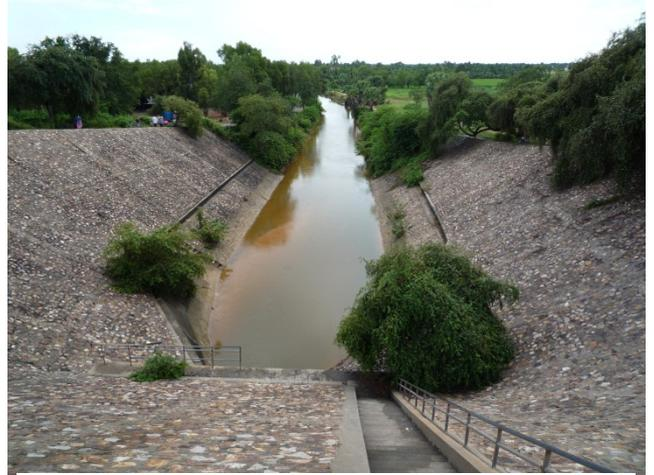
写真 2.6.1-2：取水口下流付近の護岸状況
