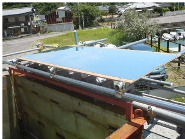
反射鏡の仕様 サイズ：2m×0.9m×2面（東西に各1面）、材質：樹脂ミラー
