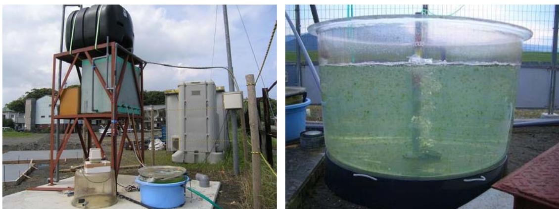
図 4.3.1-1 地下水汲み上げ施設(左)と 1t 水槽(右)
