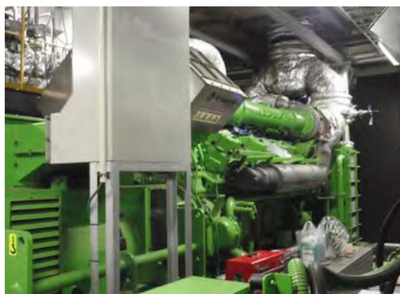
写真 2.3.2-9 ガスエンジン発電機
