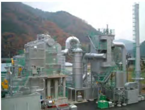
写真2.3.2-9 ボイラ・冷却塔・バグフィルター・煙突
