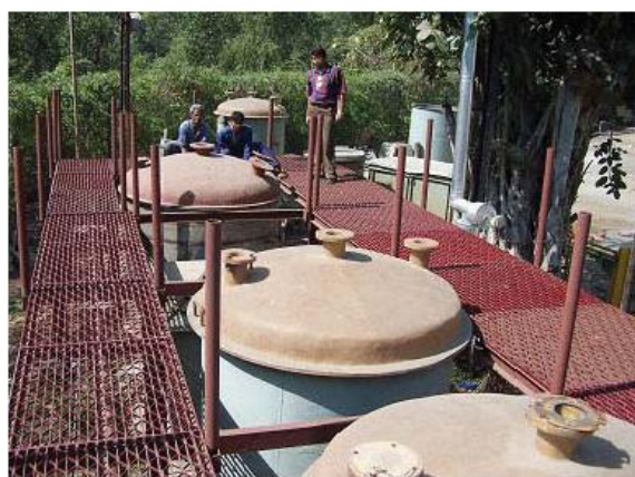
図 4.3-1 濃縮塩水からのウラン捕集パイロットプラント
