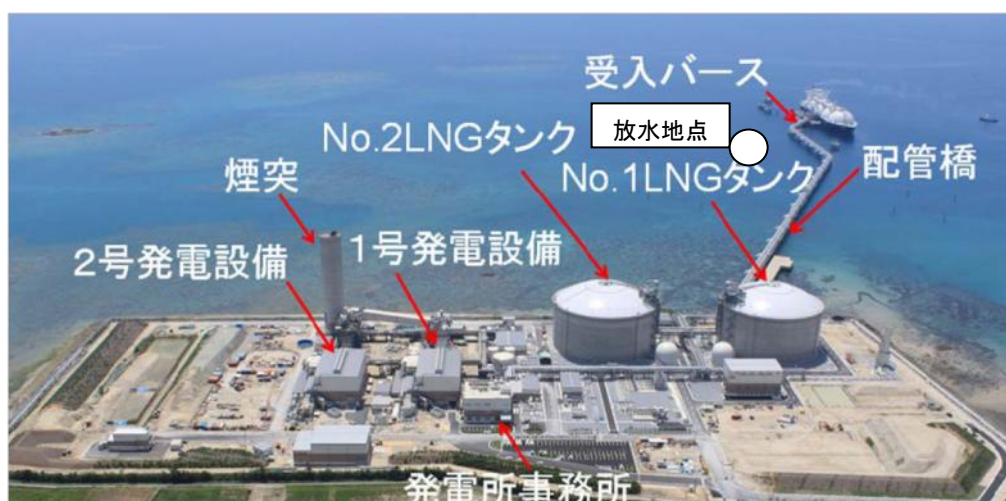
図 5.2-1 吉の浦 LNG 火力発電所
