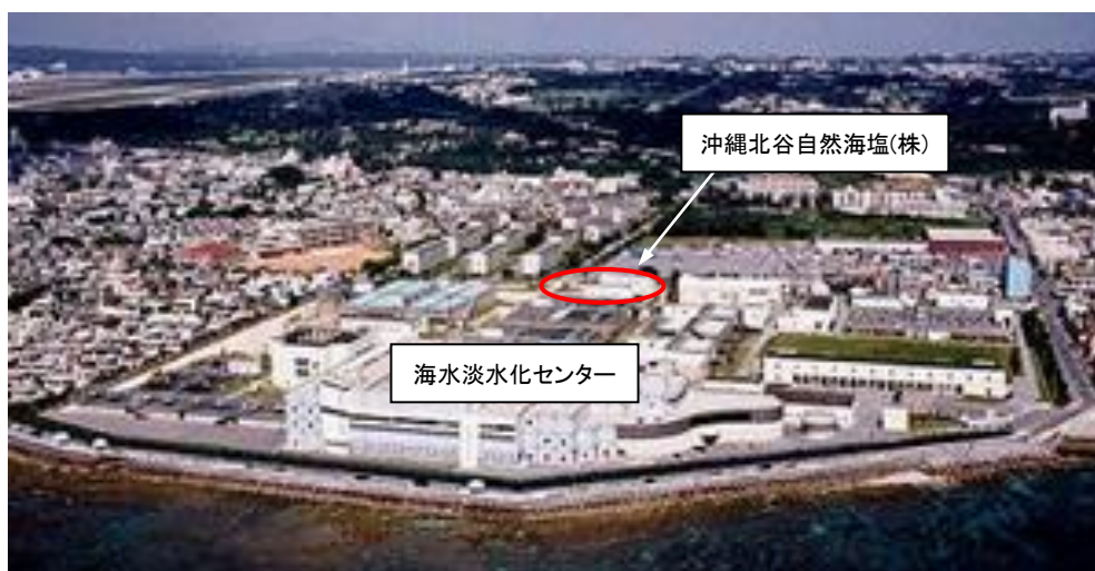
図 5.1-1 沖縄県北谷町宮城にある海水淡水化センター
