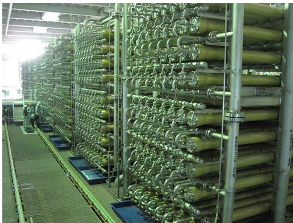
図 5.1-3 逆浸透膜モジュール
