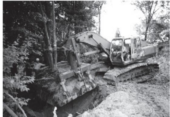
写真 4.2-2 重機移植の実施状況
