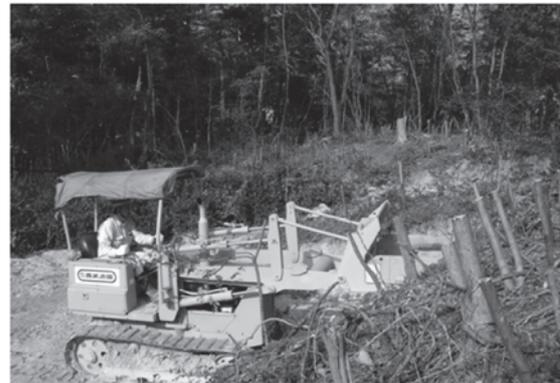
写真 4.2-3 表土ブロック移植の実施状況
