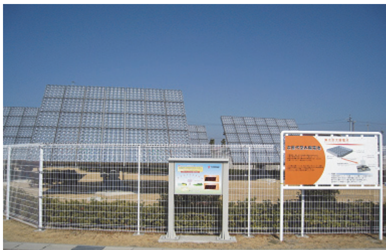
写真 1.2.1-1 集光型太陽光発電装置の設置状況
