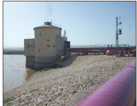
写真 4-2 貯留雨水の揚水施設
