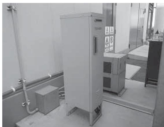
写真 5.4-4 製品の水素ガス(左)と燃料電池(右)
