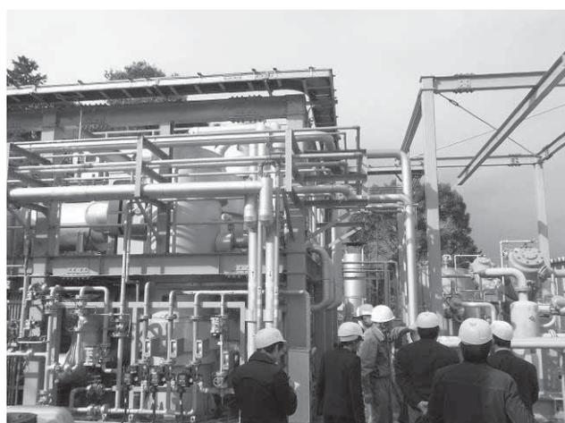
写真 5.3-4 メタノール製造装置と発電装置
