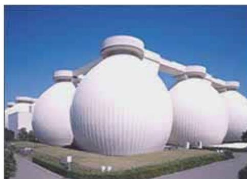
写真 2.1.3-1 下水汚泥消化槽
