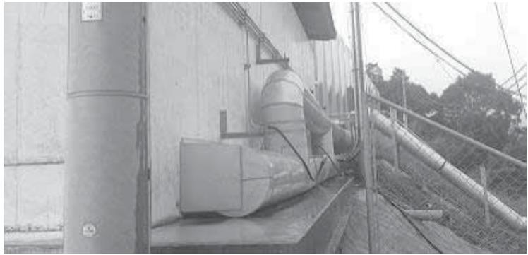
写真 5.3-11 ストックピットへの乾燥排熱パイプ
