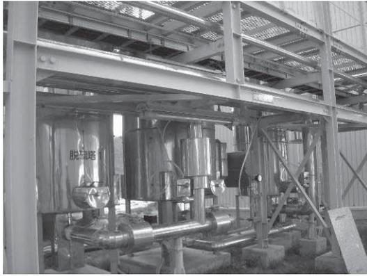
写真 5.2-8 脱硫塔・シロキサン除去塔(奥)
