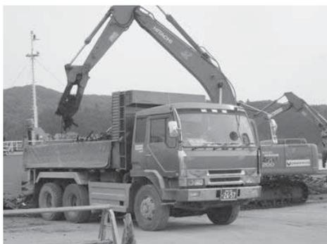
写真 1.3-3 木くずの積み込み状況
