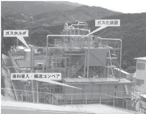
写真 5.3-2 ガス化装置全体
