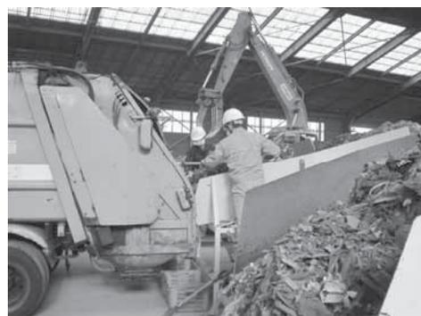
写真 1.3-6 パッカー車への積替作業
