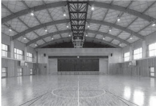
写真 2.2.3-1 集成材を用いた木造建築
