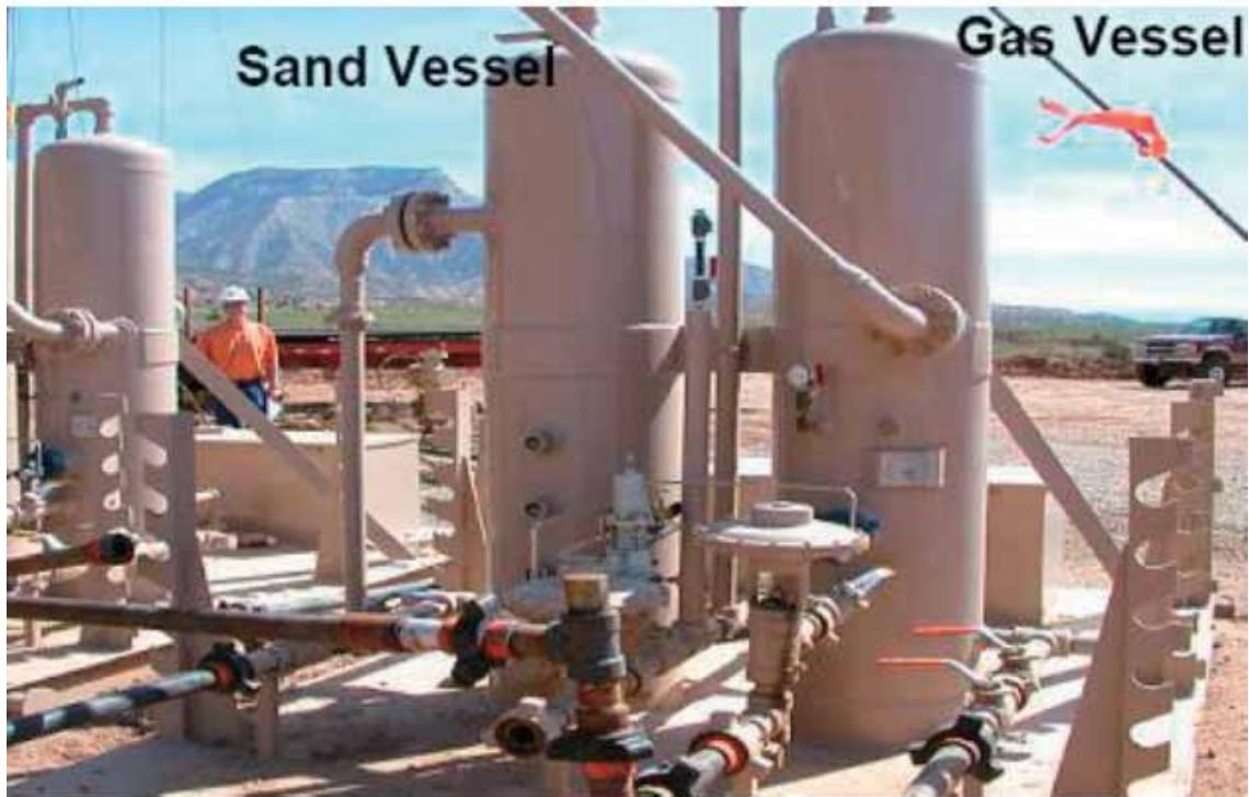
図 2.4.8.3 設置型 RECs (Reduced Emission Completions) 装置
