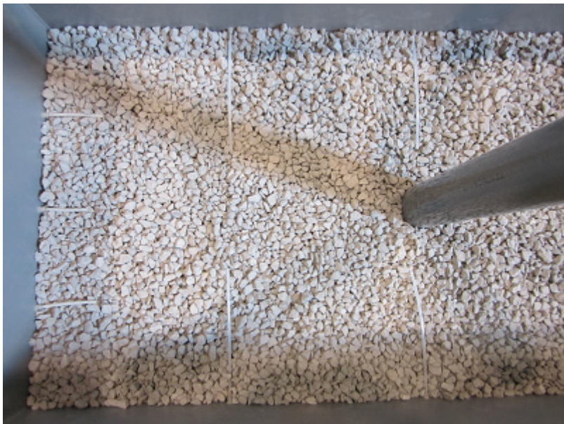
写真 4. 2-2 土槽内排水管設置状況
