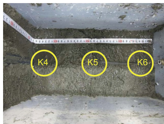
中部排水孔試料採取位置
