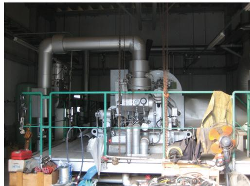
写真 5.1-5 蒸気タービン
