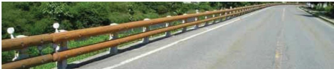
写真 2.3.1-6 木製ガードレール（ビスタガード）の施工例
