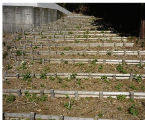
写真 2.1.3-1 木製遮音壁（長野県のカラマツ製遮音壁）と丸太筋工の事例
