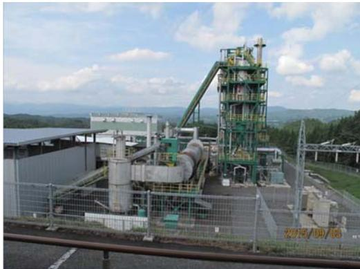
(燃焼塔と燃料移送コンベア)
