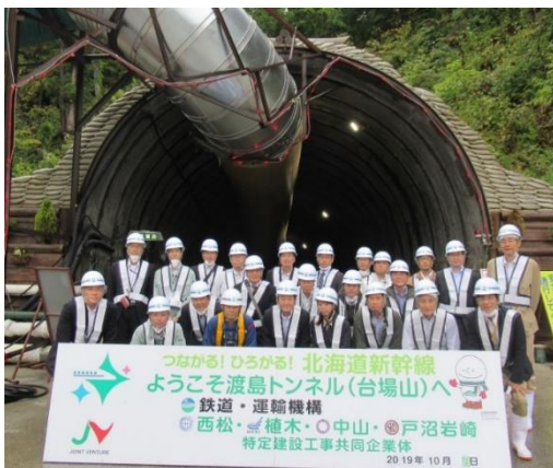
渡島トンネル斜坑坑口
