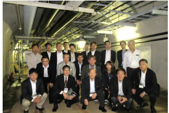
青函トンネル体験坑道 (この奥で新幹線トンネルと接続)
