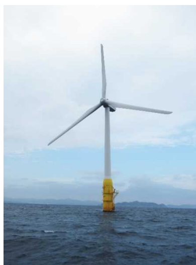
船上から見た浮体式洋上風力発電所
