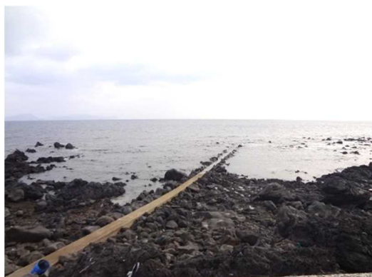
送電ケーブル陸揚げ地点
