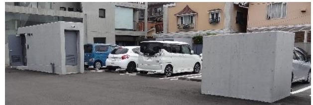
核シェルター外観
