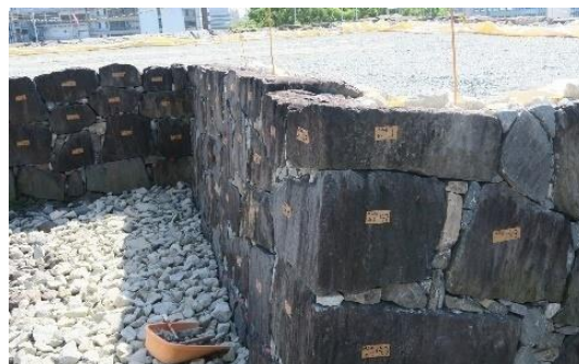
熊本城 復旧工事
