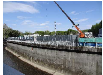
石神井川対岸から見た現場
