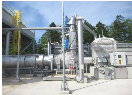
屋外設置の森バイナリー発電所のタービンと発電機
