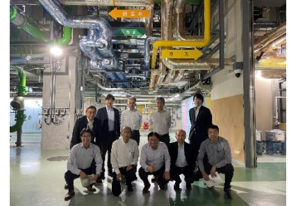
新さっぽろエネルギーセンター内部
