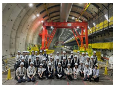
トンネル坑内 (内部構築箇所)
