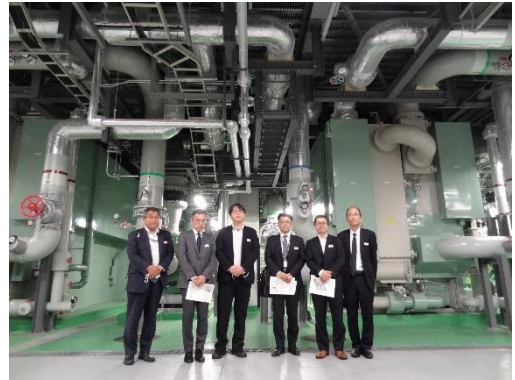
八重洲エネルギーセンターにて
