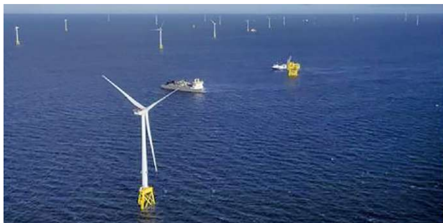
日本企業の参画が進む浮体式洋上風力発電
