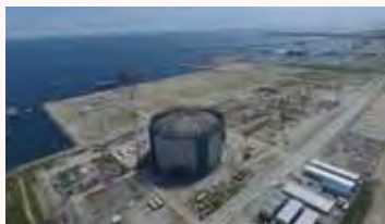
工事中の相馬LNG基地
