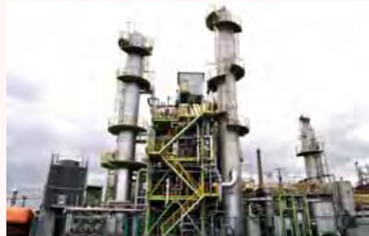
設備能力：120ton/日 原料ガス：製鉄所熱風炉排ガス 事業者：エア・ウォーター炭酸(株) 設置場所：新日鉄住金(株) 室蘭製鉄所構内 用途：各種産業用(製鉄、溶接、食品等)
