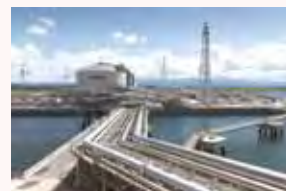
直江津LNG基地
