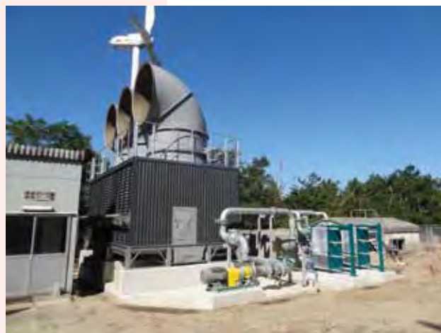
中条油業所・ヨード工場内に現在建設中の新しいかん水処理装置 (かん水に含まれるフェノールを生物処理により除去することにより、環境への負荷を軽減するとともにヨウ素の回収率を向上)
