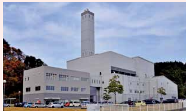
岩手沿岸南部クリーンセンター外観
