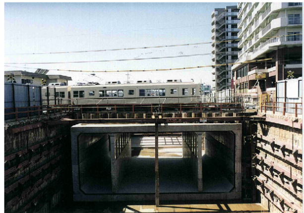
図 4.4.2-7 設置された箱形ルーフ（左写真）と土被り浅く設置された函体（右写真）
