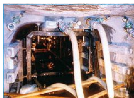
●モルタル注入状況
