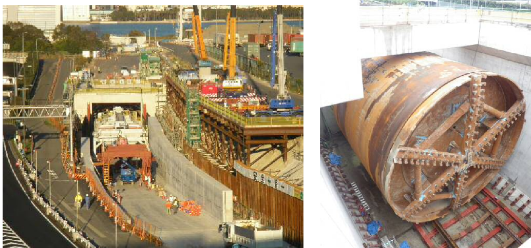
図 4.4.2-5 地上発進状況（左写真）と地上到達状況（右写真）
