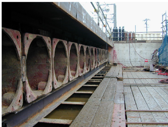
図 4.4.2-7 設置された箱形ルーフ（左写真）と土被り浅く設置された函体（右写真）
