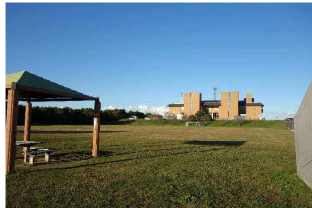
図4.2.3-4 調圧水槽地上部
