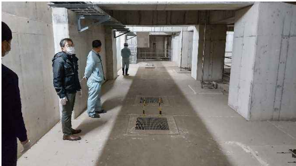
図4.4.3-13 フラッシュゲート直上部状況
