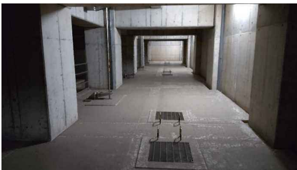
図4.4.3-15 調節池の内部状況
