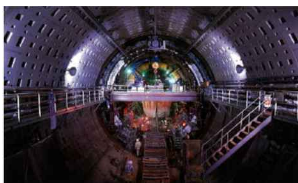
写真 3.1.3-4 トンネル施工状況
