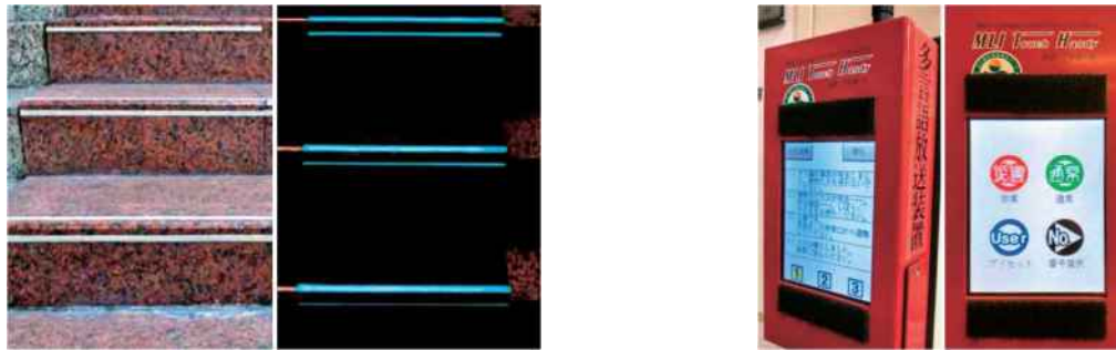
図 2.2.4-1 階段に設置された高輝度蓄光材(左)、多言語対応型非常放送設備(右)
