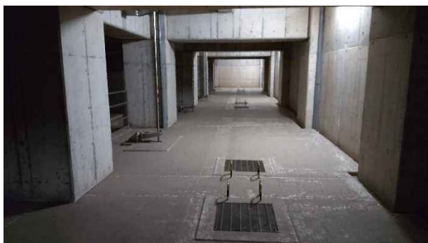
図 4. 4. 4-6 調節池の内部状況 (図 4. 4. 3-15 再掲)
