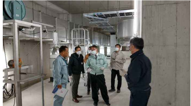
図4.4.3-10 機械室排気ダクト視察状況
