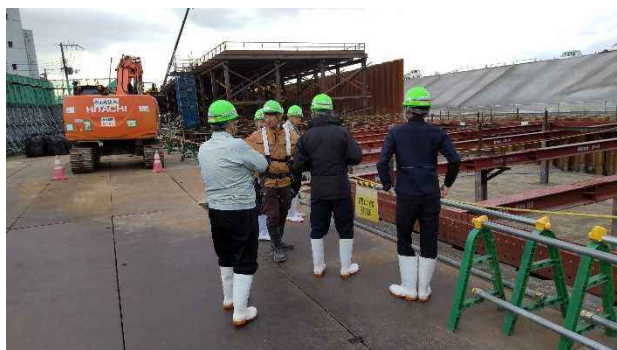
図4.5.2-2 現地視察の状況
