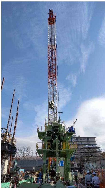
図4.4.3-7 掘削揚土クレーンの展示状況
