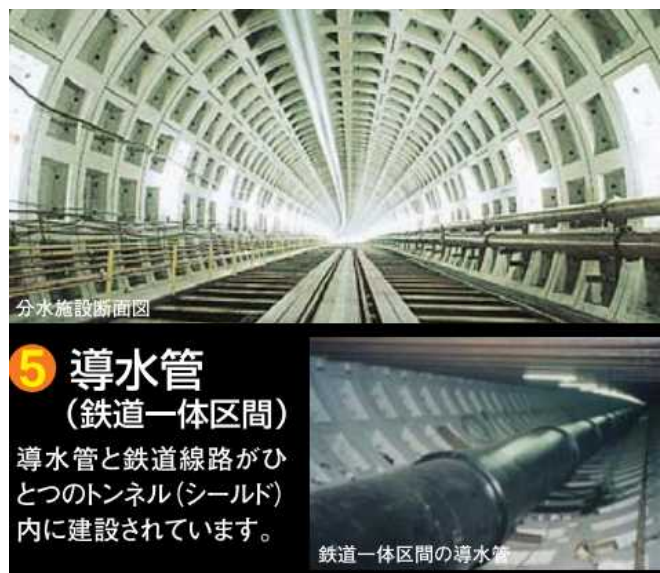
図 2.4.3-2 鉄道下導水管
