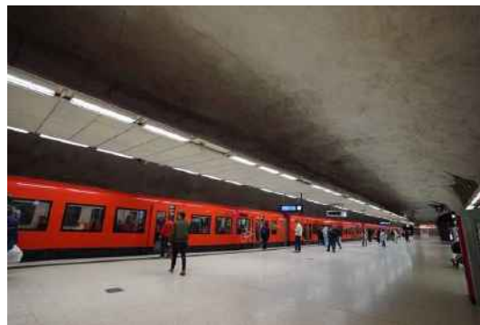
図 2.1.4-2 核シェルターを兼ねたヘルシンキ市内の地下駅舎
