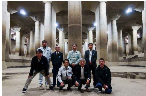
図4.2.3-3 調圧水槽内部
