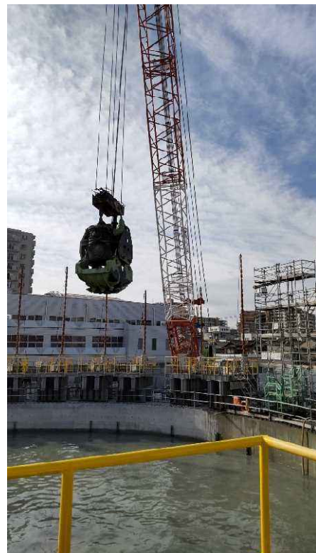
図4.4.3-8 掘削揚土クレーンの掘削状況
