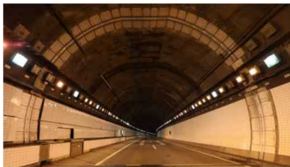
写真 3.1.3-3 海底トンネル
