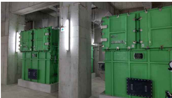
図4.4.3-11 機械室脱臭装置視察状況
