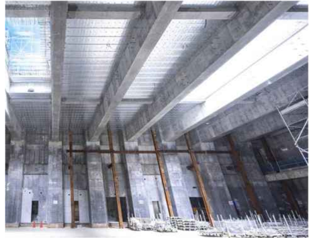
写真 3.1.3-1 B-2 街区東棟地下
